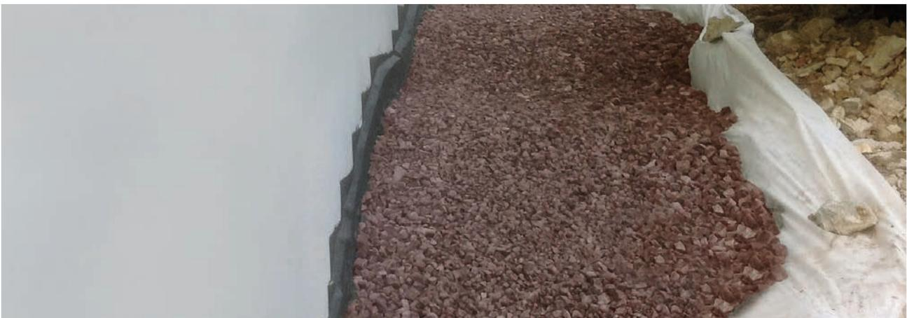
Auffüllen des Arbeitsgrabens, lagenweises Verdichten von veriso RED Blähglasschotter
