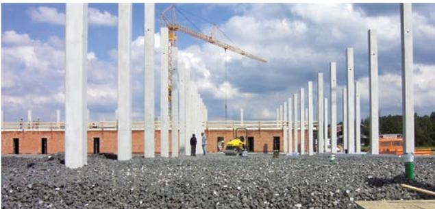
Kapillarbrechend: ersetzt die kapillarbrechende Schicht
