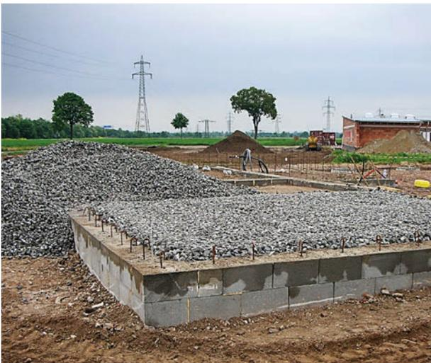
Bodenplatten mit **veriso Schaumglas** werden in der Regel ohne Streifenfundamente ausgeführt. Sollten die baulichen Anforderungen aber einmal Streifenfundamente erfordern (Hanglage, Niveauerhöhung), so ist **veriso Schaumglas** mit seinen Eigenschaften der optimale Baustoff zwischen den Fundamenten. Als Schüttmaterial ist **veriso Schaumglas** deutlich einfacher und schneller zu verarbeiten als Plattenware. Kein Zuschneiden, einfach schütten, verteilen und verdichten.
