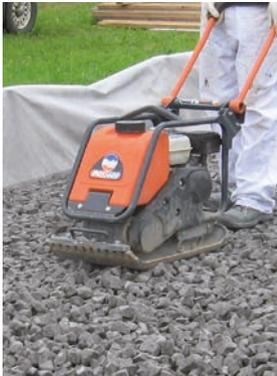
Für die Verarbeitung von veriso Schaumglasschotter empfehlen wir vorwärtslaufende, leichte Rüttelplatten mit leichtem Vortrieb. Rüttelplatten mit Vor- und Rücklauf (reversierbare Modelle) sind für die Verdichtung nicht geeignet. Das Verdichtungsverhältnis 1,3:1 erreicht man z.B. mit Rüttelplatten ~ 100 – 120 kg, Frequenz 80 – 100 Hz, und einer Arbeitsbreite ≥ 500 mm.
