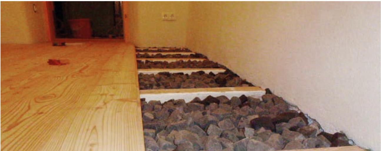
Der Fußbodenaufbau mit **veriso Schaumglas** eignet sich sowohl für den Neubau, als auch für Sanierungen in unterschiedlichen Anwendungen. Besonders bei alten Gebäuden ist bei der Sanierung von Fußböden die verfügbare Aufbauhöhe begrenzt.
