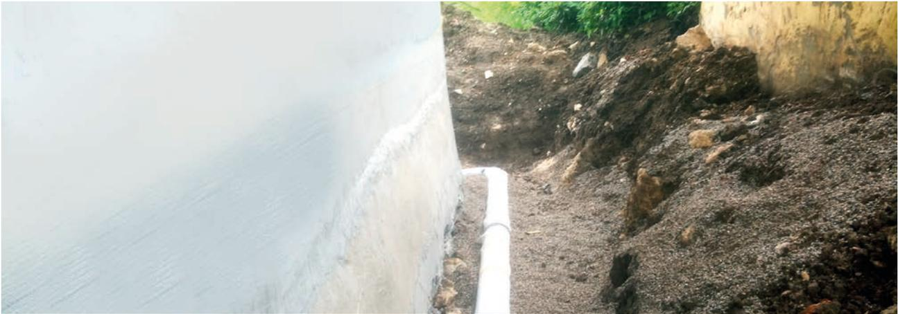
Freilegen des Mauerwerks, Abdichtung nach DIN, Herstellung einer Drainage
